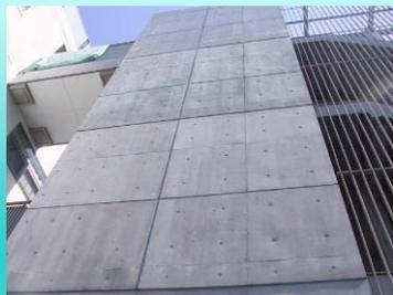
例えば、コンクリート打ち放し面にコーティングすれば、酸性雨や風化等の劣化要因から、コンクリートを保護します！
