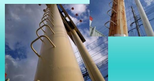
進行する赤錆を安定・不活性な黒錆に変換して固定させる錆転換剤を使用します。さらに、その上から驚きの防錆効果のガラスコーティングで保護します。
