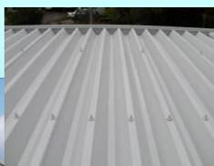
従来型遮熱塗料では塗膜表面の汚れや劣化により性能が落ちてしまうことが懸念されていましたが、ガラスコーティングすることにより、長期間建物を保護でき、美しい外観を保つとともに、性能を維持します。
