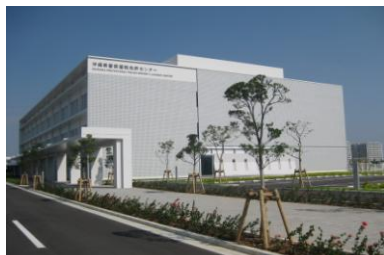
沖縄県運転免許センター外壁
