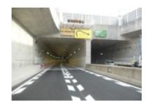
トンネル内装に当社常温ガラスコーティング(HLG)システムをご採用いただくことにより、排気ガス汚れの付着を防止するとともに清掃性の向上につながります。ドライバーの視線誘導ラインを綺麗な状態に保つため、安全運転に寄与いたします。(他トンネルでも多数実績あり。)
