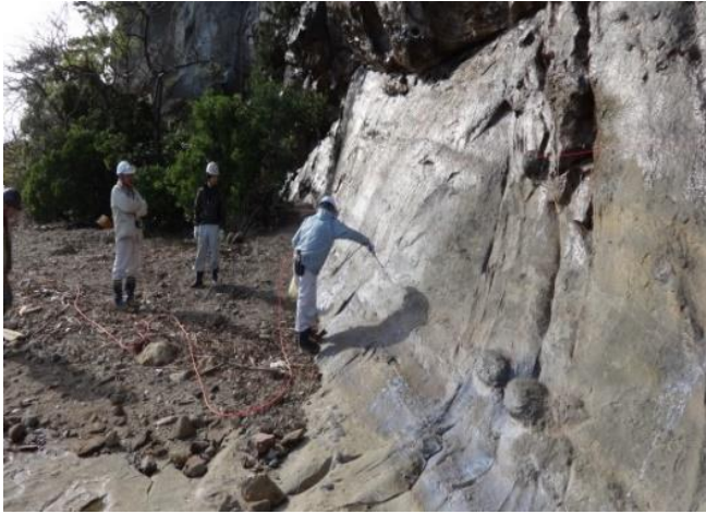
ガラス質コーティング（艶消） 仕上げ施工
