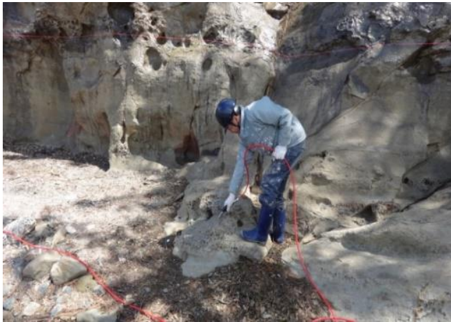
素地清掃作業
