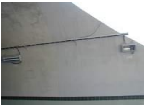
中塗り SL100クリアツヤ消し 塗布後
