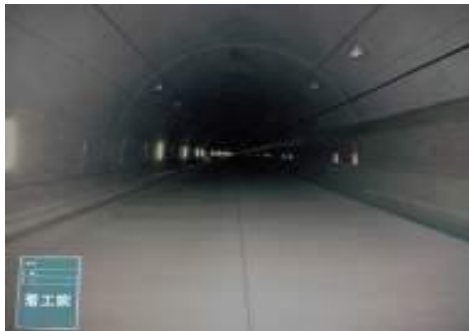
墨出し・養生工
