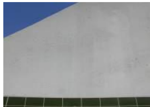
上塗り SL600クリアツヤ消し 塗布後
