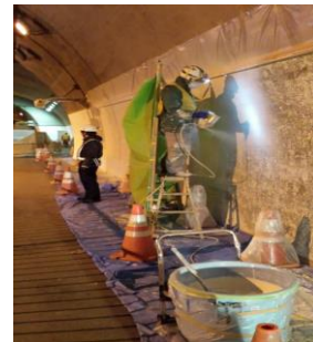
下地調整工 下地調整フィラー塗布
