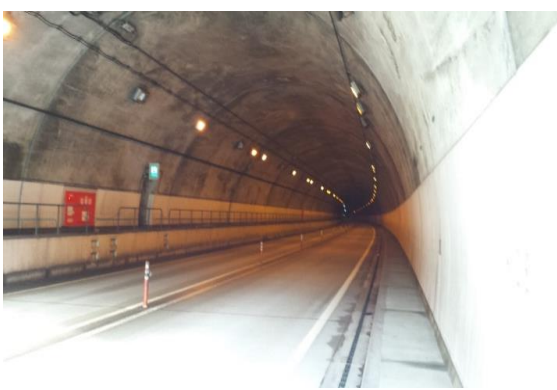
トンネル内部状況
