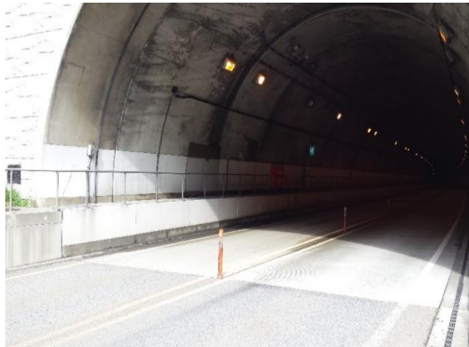
坑口付近状況
