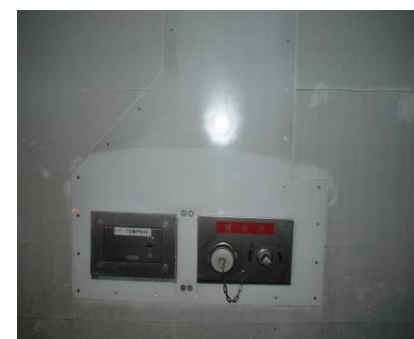
トンネル内部 清掃前
