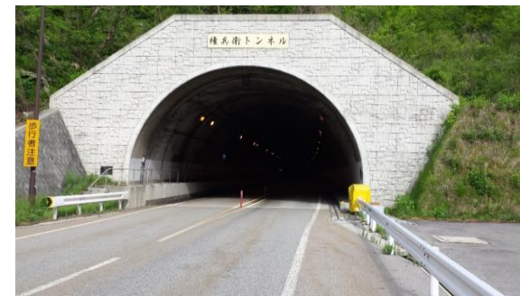
トンネル坑口付近状況
